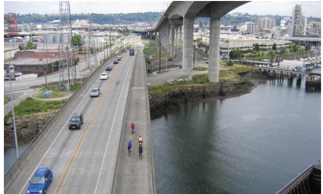
Puente de bajo nivel mirando al este.
